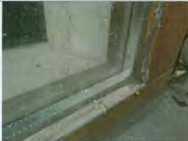
Foto Nr.9. Koka konstrukcijas logs ar divstikla paketi.
