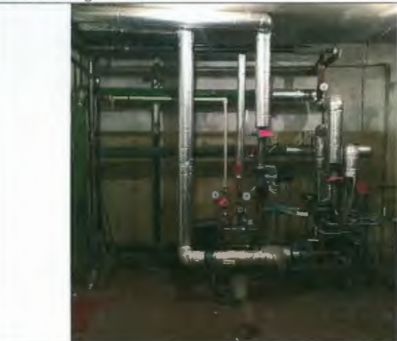
Foto nr.5. Izbūvētais siltummezgls ēkā ar lietru 002.
