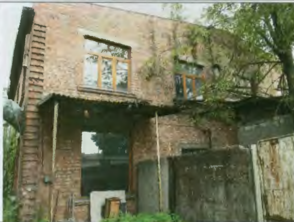
Foto Nr.17. R fasāde
