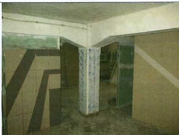
Foto Nr.34. Karkasa elementi – dzelzsbetona kolonnas un rīgeļi
