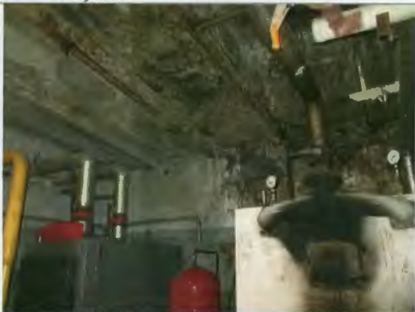
Foto Nr.19. Pārsegums katla telpai.
