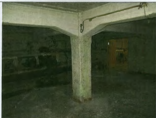
Foto Nr.33. Karkasa elementi – dzelzsbetona kolonnas un rīgeļi
