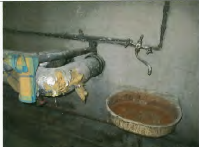
Foto nr.6. Maģistrālo apkures cauruļvadu izvads no ēkas ar literu 001 uz literu 002, kurā attiecīgi ir izbūvēts siltummezgls (skatīt Foto nr.5.).
