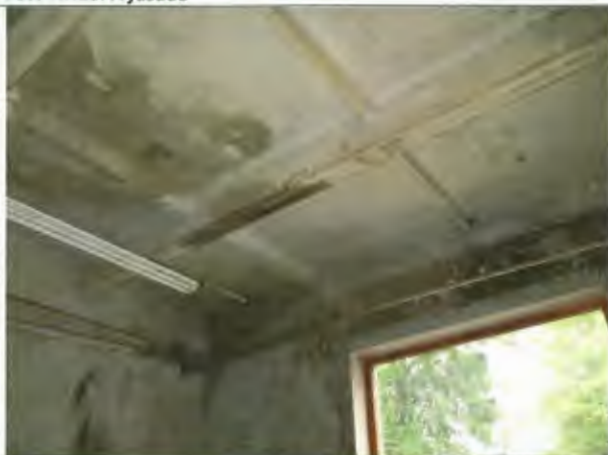
Foto Nr.20. Mitruma ietekmē esošs pārsegums
