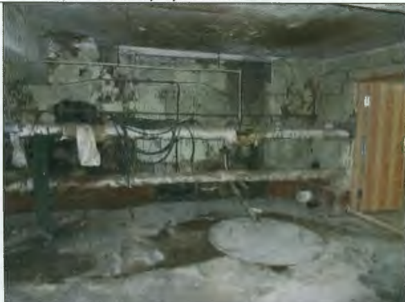
Foto Nr.7. Ēkas pagrabā atrodosie apkures cauruļvadu siltinājums ir novecojis.
