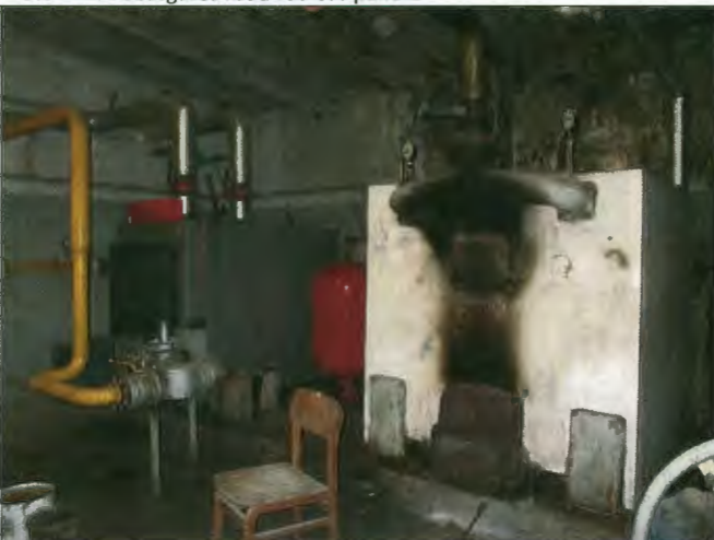
Foto nr.3. Dabaszgāzes apkures katls un ar koksni kurināmas apkures katls.
