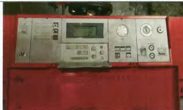
Foto nr.1. Dabaszgāzes katla vadības panelis.
