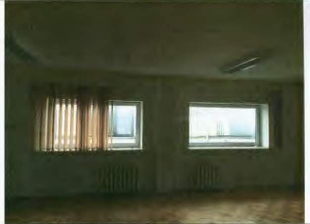
Foto Nr.2. Ēkā izveidota viencauruļu apkures sistēma
