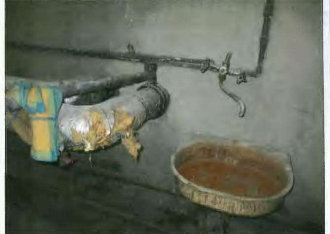
Foto nr.6. Maģistrālo apkures cauruļvadu izvads no ēkas ar literu 001 uz literu 002, kurā attiecīgi ir izbūvēts siltummezgls (skatīt Foto nr.5.).
