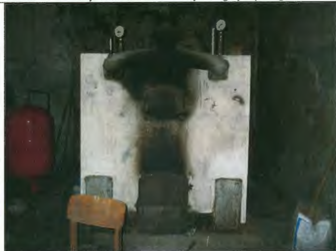
Foto nr.6. Koksnes apkures katls. Netiek ekspluatēts.
