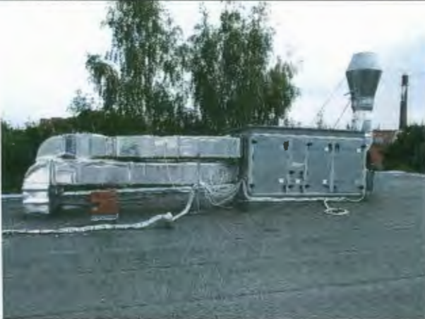
Foto Nr.7.,8. Ventagregāts uz ēkas jumta
