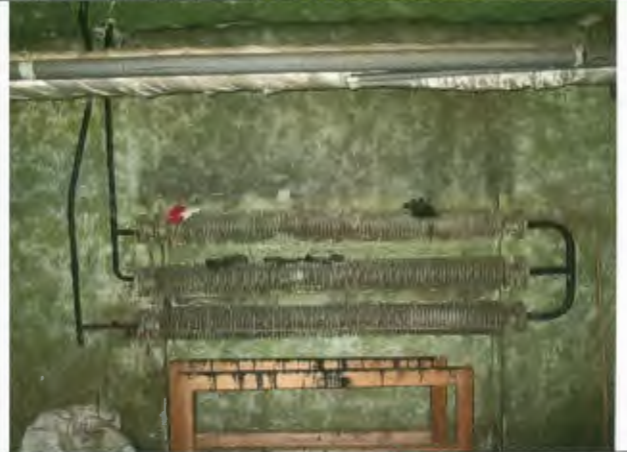
Foto Nr.4. Apkurināmā pagraba radiators
