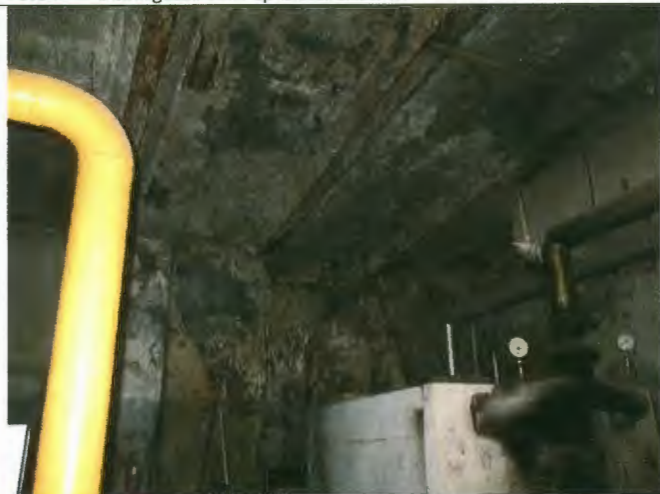
Foto nr.4. Katlu mājai mitruma ietekmē bojāts augšējais pārsegums.
