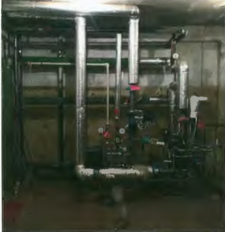
Foto nr.5. Izbūvētais siltummezgls ēkā ar lietu 002.
