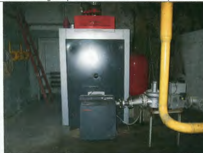
Foto nr.5. Dabaszgāzes katla deglis - Max Weishaupt GmbH WG40N/1-A.
