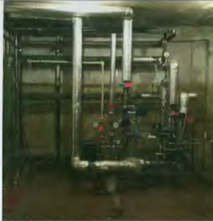
Foto Nr.1. Ēkas siltummezgls
