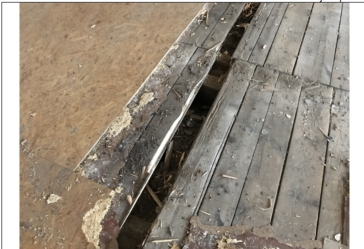
Foto Nr.F09 – Atsegums Nr.6 – koka sijas ar izdedžu aizpildījumu
