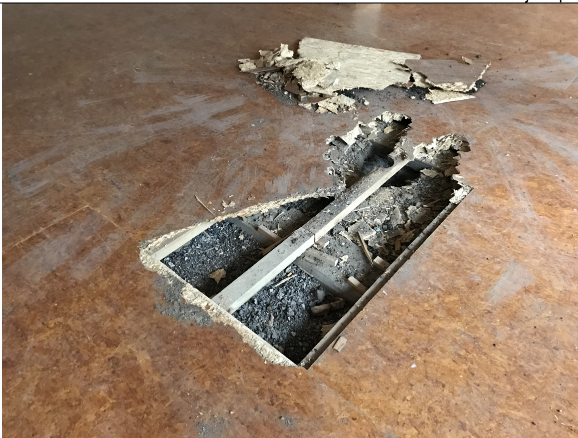
Foto Nr.F05 – Atsegums Nr.2 – koka sijas ar izdedžu aizpildījumu
