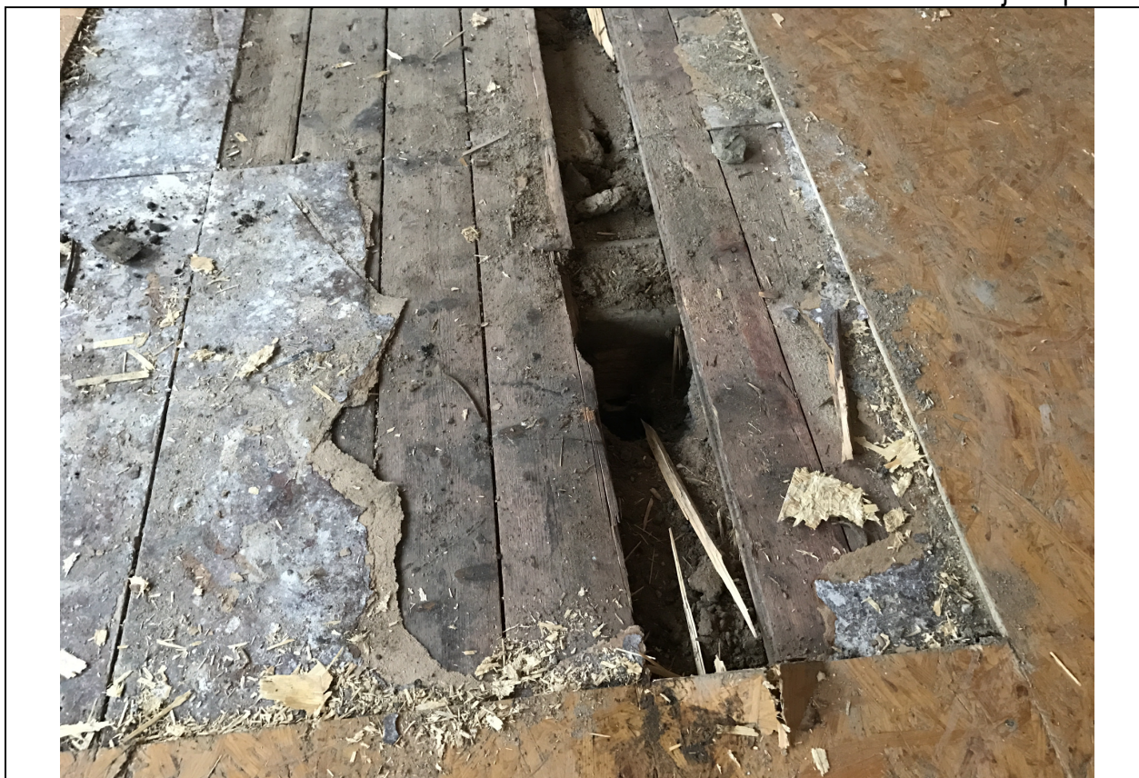
Foto Nr.F07 – Atsegums Nr.4 – koka sijas ar izdedžu aizpildījumu
